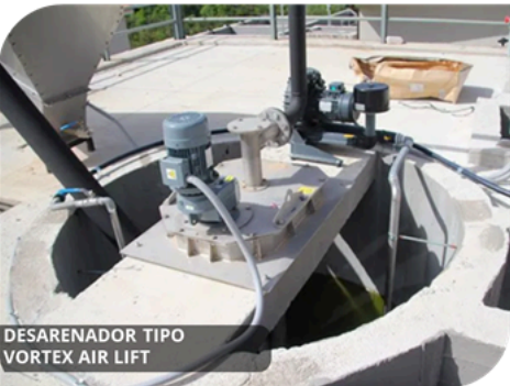
DESARENADOR TIPO VORTEX-AIR LIFT PTAR Zarzal, Colombia.
